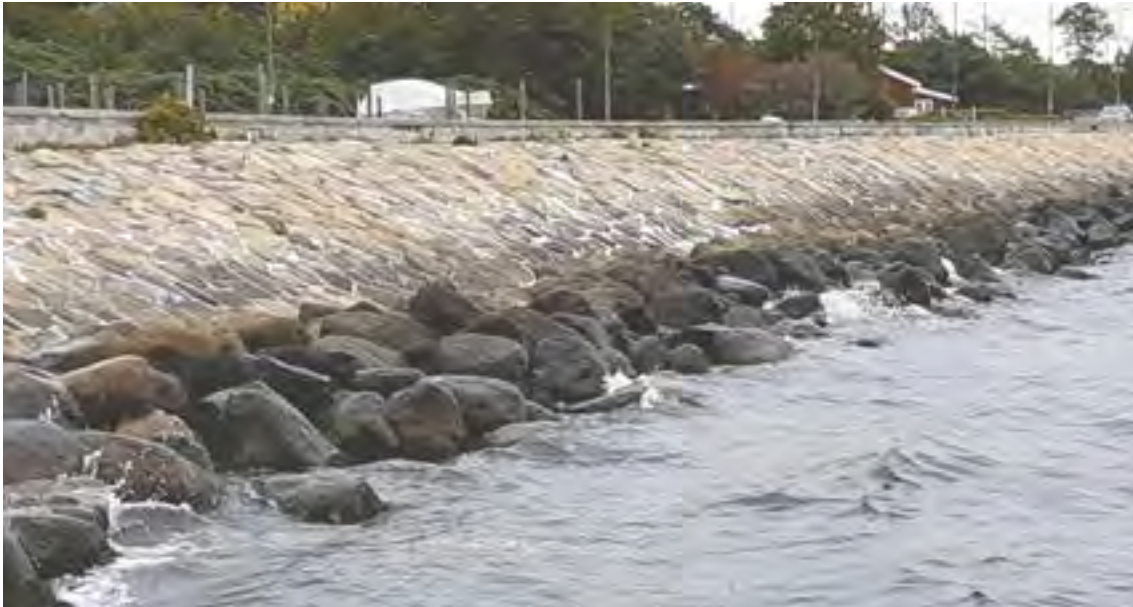
Skråningsbeskyttelse ved Trykkerdammen
